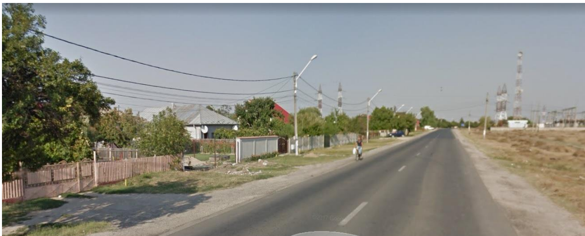
Figura 3. Imagine cu frontul construit situat în dreptul terenului studiat, pe partea opusă a DN7
